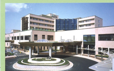
東濃中部医療センター 東濃厚生病院 瑞浪市土岐町 病床数270床
